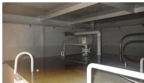
写真2 燃料小出槽のタンク上部の状況
