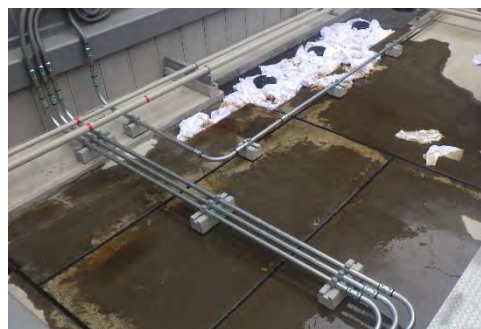
写真3 燃料小出槽外部の周辺の状況
