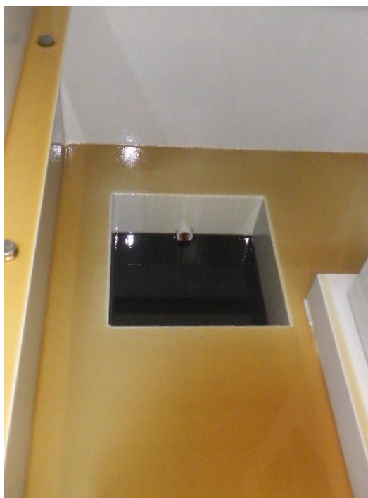
写真1 燃料小出槽のためますの状況
