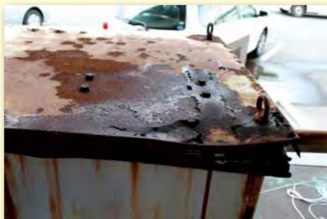
屋外キュービクルの腐食
