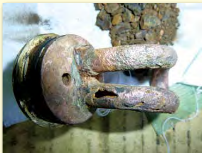
冷却水ヒータの破孔
