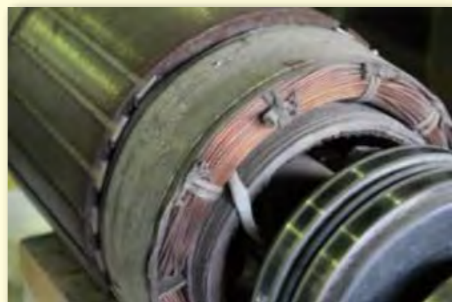
回転子巻線及び鉄心部の塵埃・発錆
