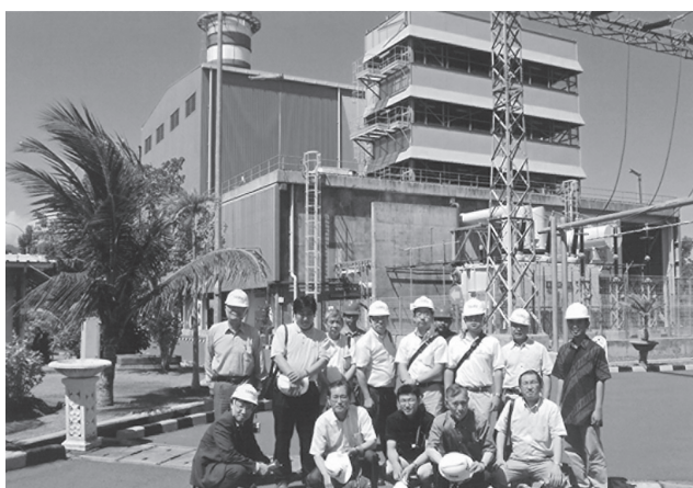
ギリマヌク火力発電所
