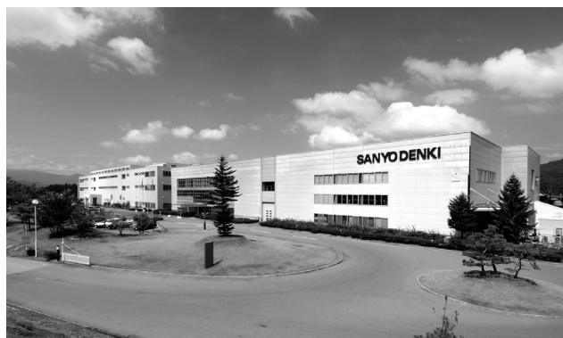
山洋電気(株)富士山工場の外観
