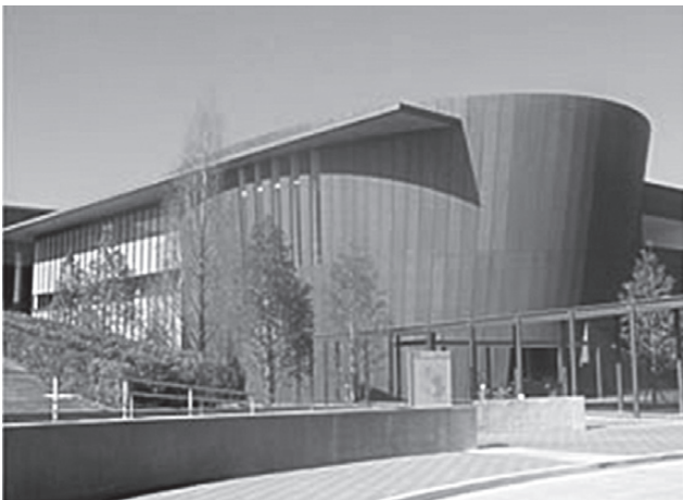
神奈川工場の外観 (写真3)
