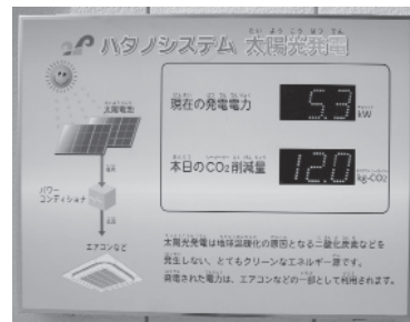
埼玉サービスセンターの屋根に設置した10kWのPVとPVモニター
