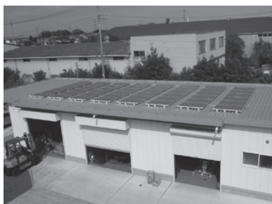
埼玉サービスセンターの屋根に設置した10kWのPVとPVモニター
