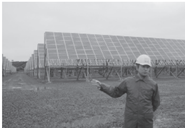
太陽光発電の架台が立ち並ぶ稚内サイト
