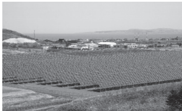
北海道電力の5,020kWメガソーラー
