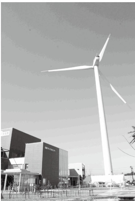
リサイクルセンター炭生館のリパワー社製1980kWの風力発電設備(愛知県田原市)
