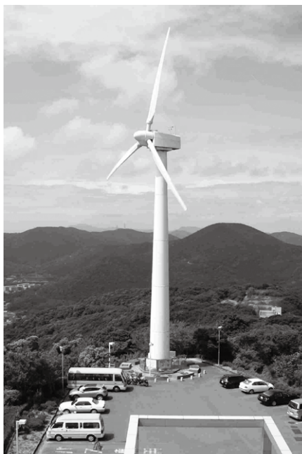
蔵王山展望台の三菱重工製300kWの風力発電設備(愛知県田原市)
