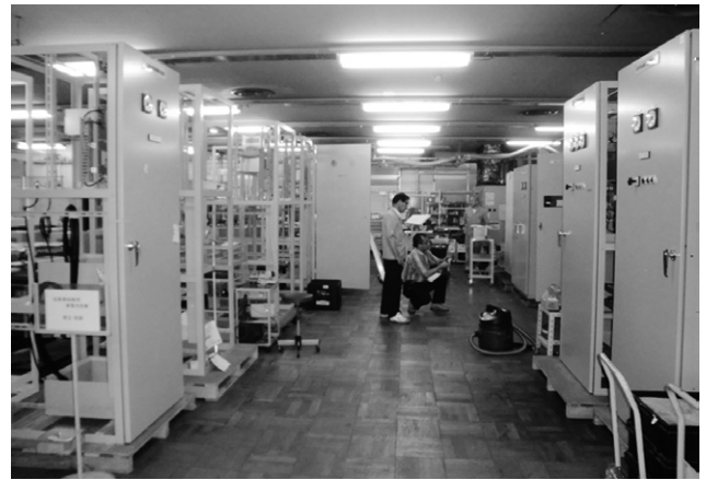
自家発始動用蓄電池充電装置の製作風景 (京都本社工場)
