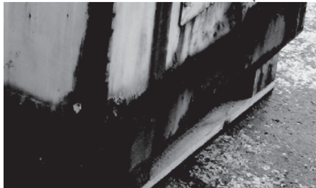
図3 側板部が発錆及び腐食し破孔
