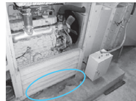
写真2 発電設備基礎台部分
