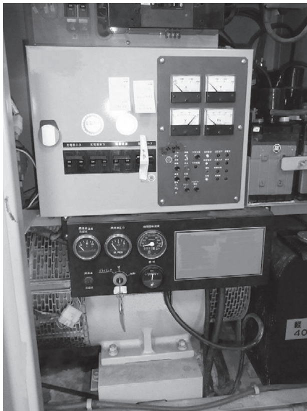
写真11 発電機及び制御装置設置状況
