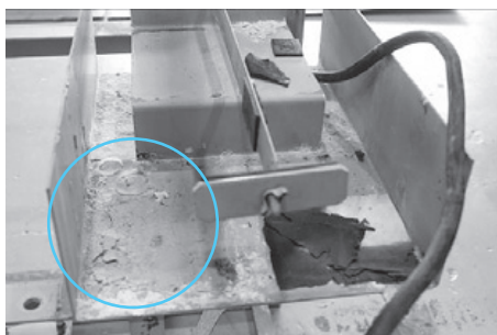
写真4 蓄電池設置スペース部分
