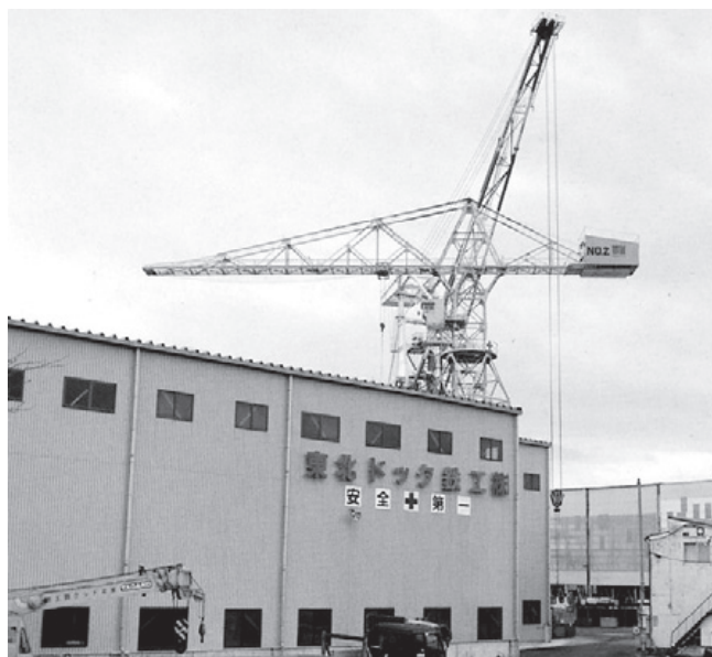
鉄構第1工場の外観
