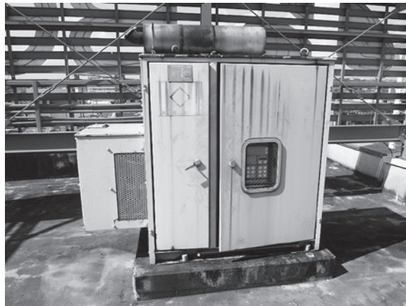
写真1 発電設備の設置状況
