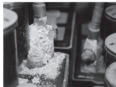
写真10 蓄電池の電解液漏れ
