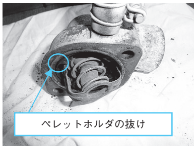
写真7 サーモスタット損傷
