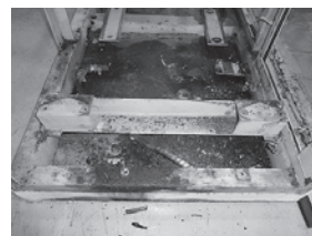
写真5 共通台板の床板部腐食及び汚損
