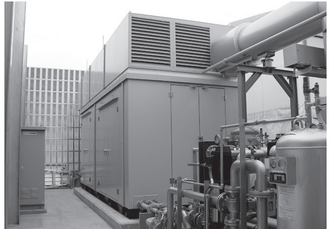
写真2 コージェネシステム(735kW)
