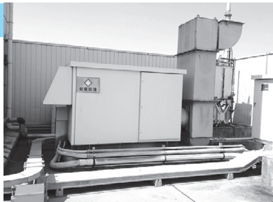
写真1：設備の全体写真
