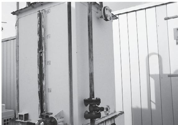
写真24：燃料容器の発錆状況
