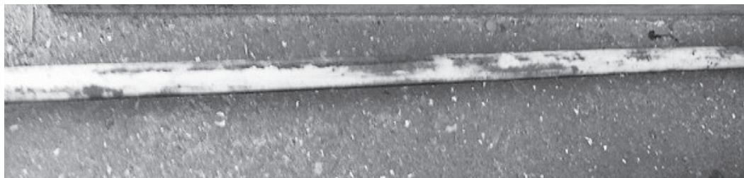
写真26：配管の発錆状況
