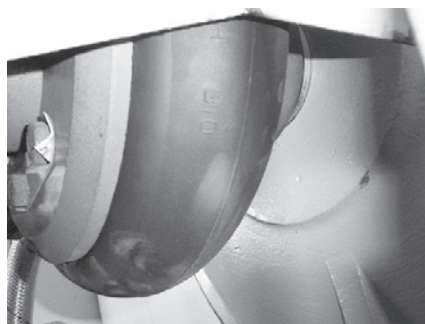
写真6：継手緩衝ゴム取付状態
