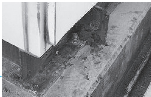
写真3：ドア・アンカー据付部発錆
