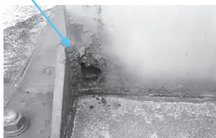
写真4：排気消音器発錆・腐食状況
