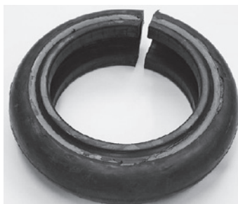
写真7：継手緩衝ゴム (調査のため取外し)
