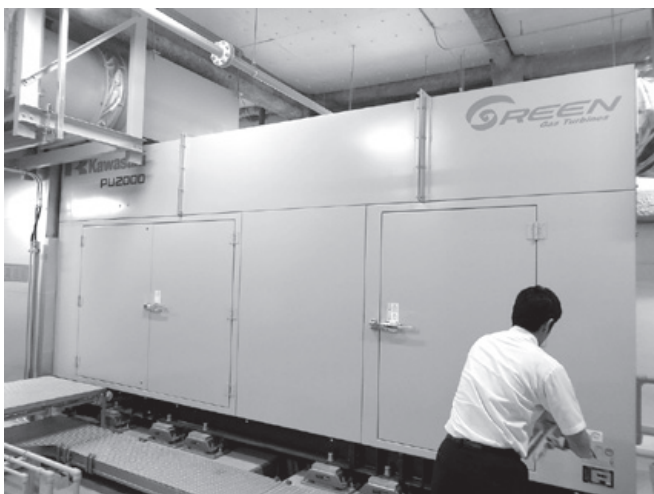
非常用ガスタービン発電設備
