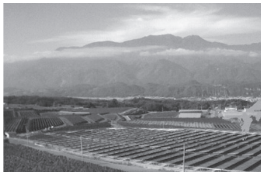
山梨県北杜市「シューワ山梨太陽光発電所」メガソーラー1.2メガ
