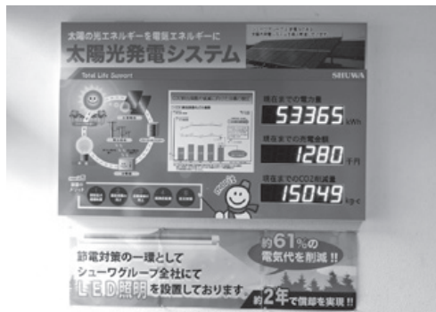
太陽光発電システムの稼働状況を見える化した
