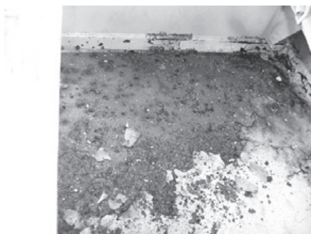
写真4：キュービクル底板の発錆
