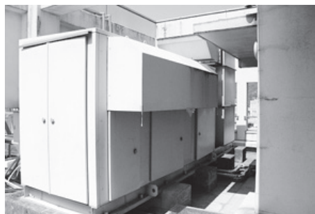
写真1：設備の全体写真
