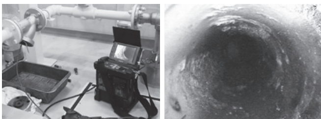
ビデオスコープ装置による診断風景(左)と配管診断画像例
