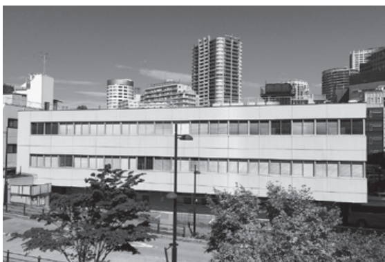
明電エンジニアリングの本社ビル
