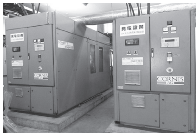
バイオガス発電設備（鹿追町）
