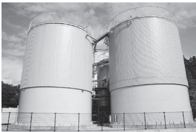
湿式発酵槽（浅麓汚泥再生処理センター）
