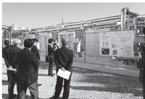
年間発電量250万kWhのバイオガス発電設備
