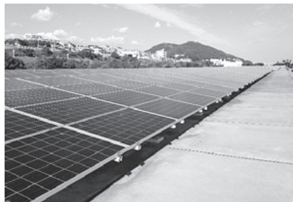
年間発電量200万kWhの太陽光発電設備
