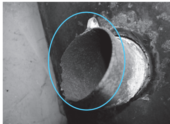
写真35：マフラ排気管出口部の腐食
