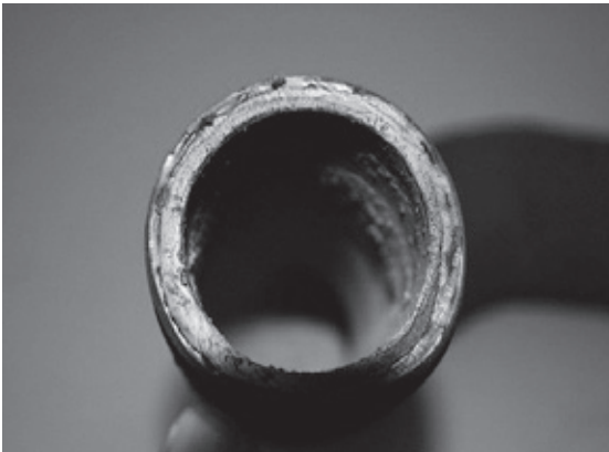
写真32：冷却水ゴムホース
