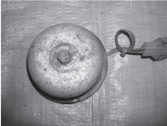
写真20：警報ベルの発錆、作動不良
