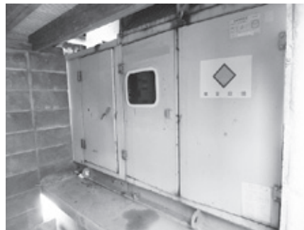
写真1：設備の全体写真
