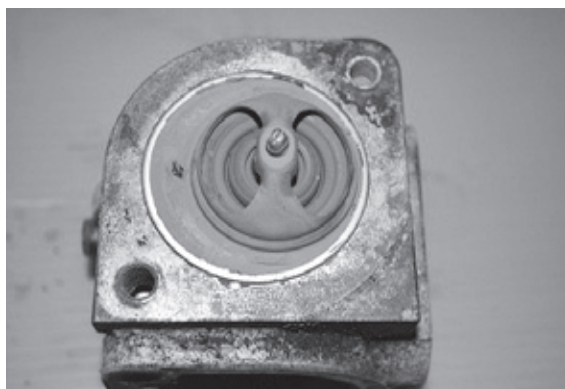
写真12：サーモスタットの発錆
