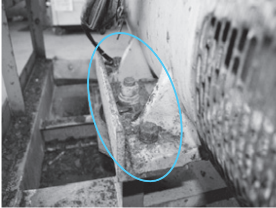
写真6：発電機固定ボルトの発錆
