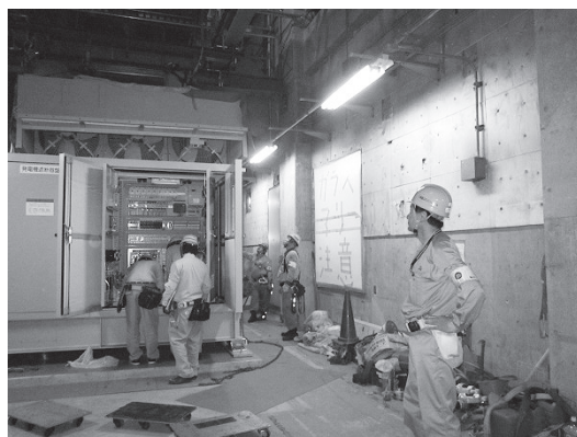
官庁施設の発電設備工事現場での黒川さん
