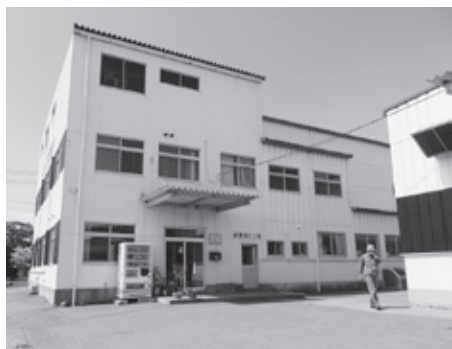
桔梗野第1工場の装置組立工場
