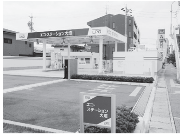
圧縮天然ガスステーション
