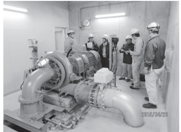
設置工事を担当した小水力発電設備
