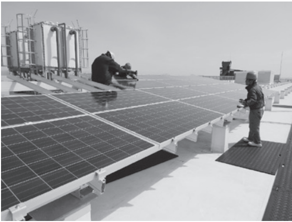
太陽光発電設備の据付工事
