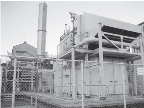
ガスタービンコージェネシステム5基を設備した
