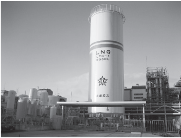
コージェネ用LNG燃料タンク
