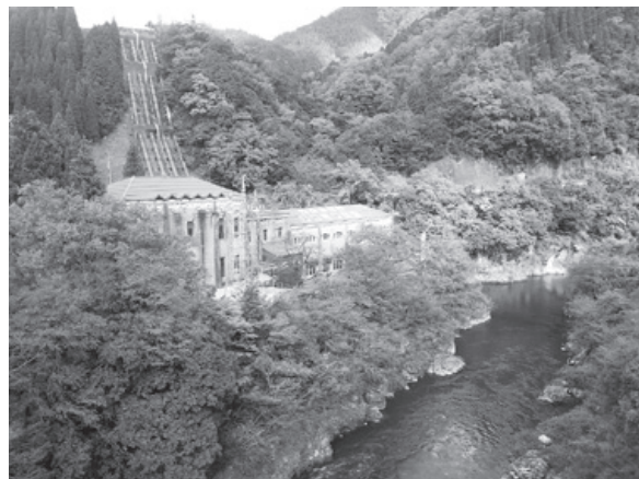
イビデンの東横山水力発電所
