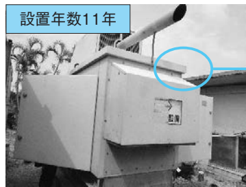
設置年数11年 写真1：屋外設置のキュービクル外観
