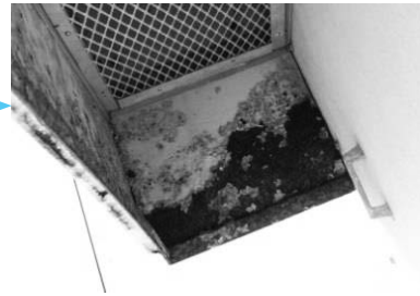
写真2：吸気ガラリ部内側に発錆
