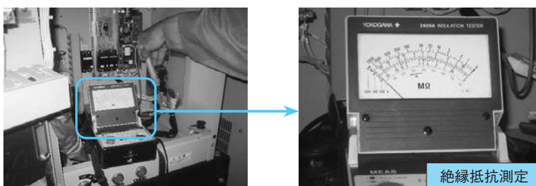
写真12：界磁巻線の絶縁抵抗測定状況（界磁巻線～遮断機～大地間）
