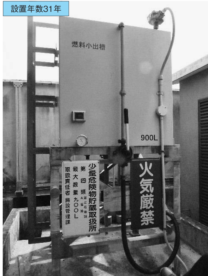
写真18：屋外設置の燃料小出し槽
