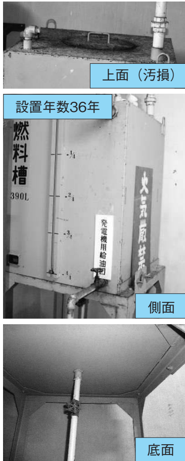
写真17：屋内設置の燃料小出し槽
