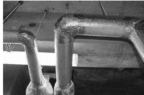
写真21：キュービクル外の排気煙道
