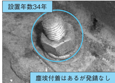
設置年数34年 写真3：アンカーボルト（ステンレス材） 塵埃付着はあるが発錆なし
