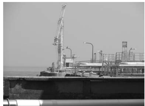
LNG受入設備
