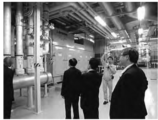
西地区の815kWコージェネシステム
