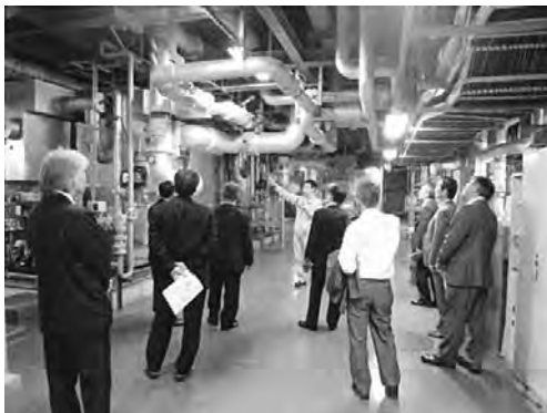
東地区の400冷凍t 廃熱投入型ガス吸収式冷温水機
