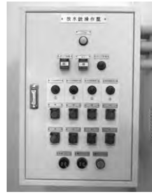
放水銃の操作盤
