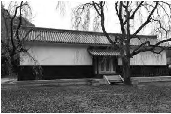
北大手門に面したポンプ室
