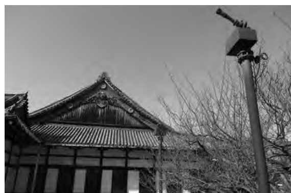
ポールの上に設置された放水銃
