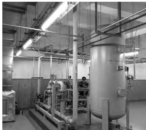
写真4 都市ガス設備（発電機棟2階）
