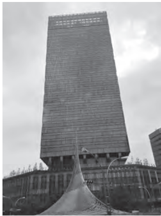
写真1 大名古屋ビルディング全景
