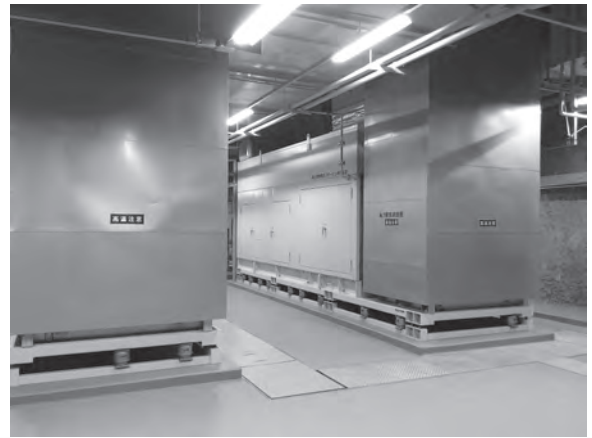
写真2 ガスタービン発電設備
