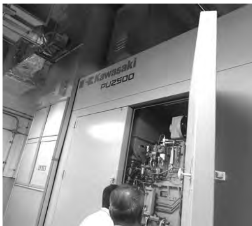
写真2 ガスタービン発電設備
