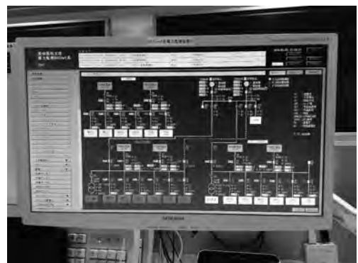
写真5 電源システムを映したモニター
