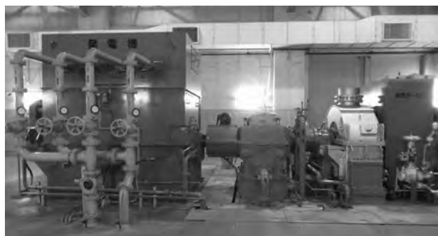
写真1 蒸気タービン発電設備
