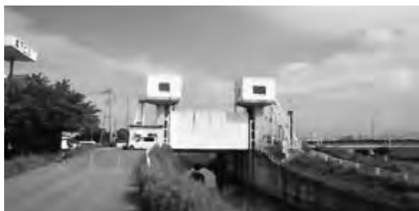
写真-8 四分川逆水防止ゲート（全景下流側より）
