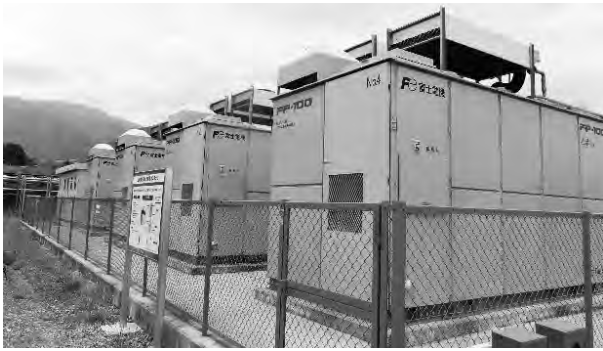
写真-2 燃料電池設備（4台）
