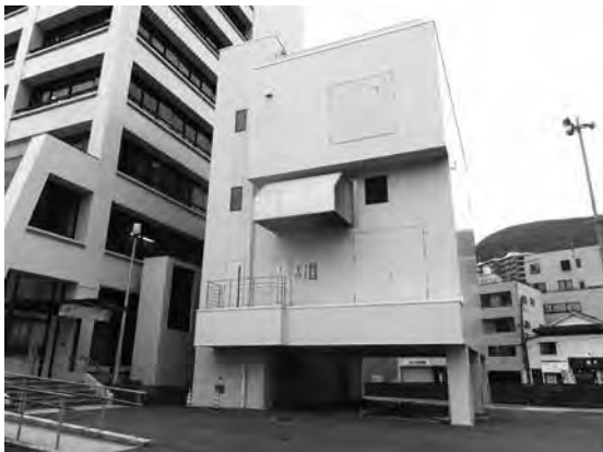
1,000kVAの自家発を設置している非常用電源棟
