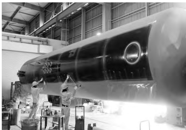
鋼製地下タンクのFRP被覆の準備作業
