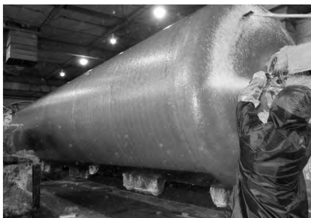
鋼製地下タンクのFRPの被覆作業
