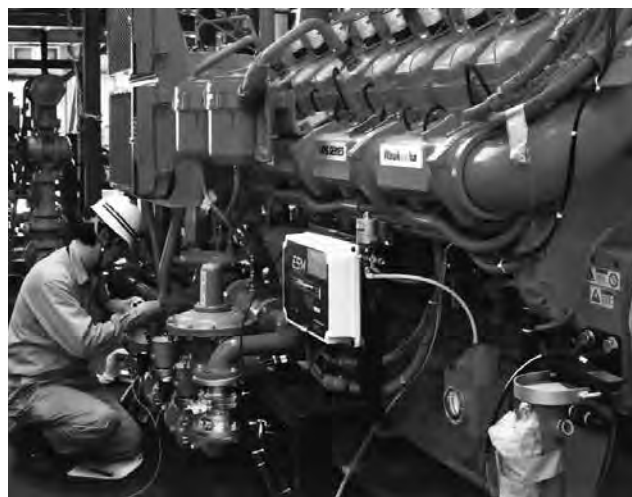
ガスエンジン
