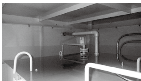
写真2 燃料小出槽のタンク 上部の状況
