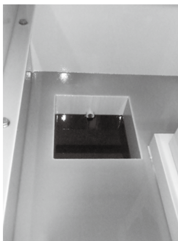
写真1 燃料小出槽のため ますの状況
