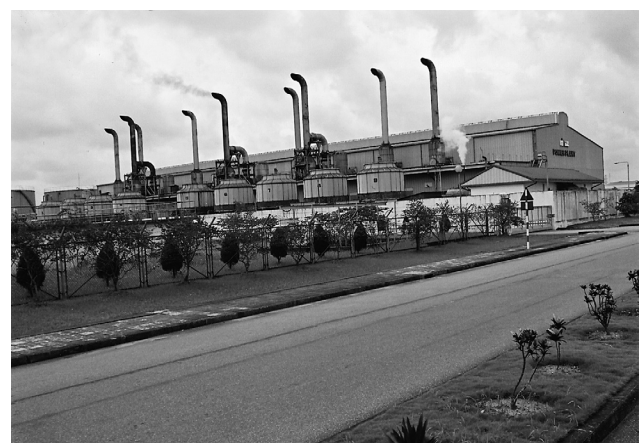
野村ハイフォン工業団地にある5万kWディーゼル発電所
