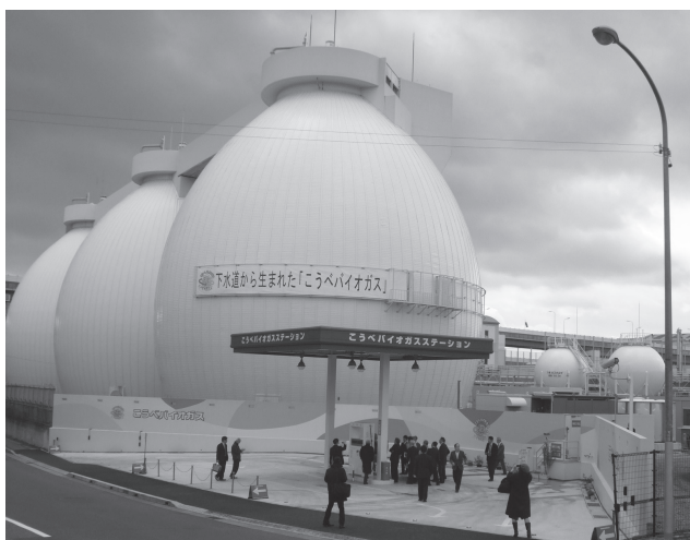
ガスステーション(手前)と卵形の消化タンク(奥)
