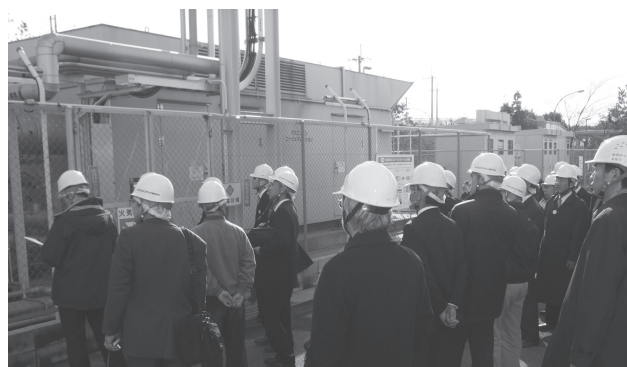
730kW バイオガスエンジンコージェネ
