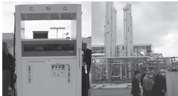
ガス充てん装置
