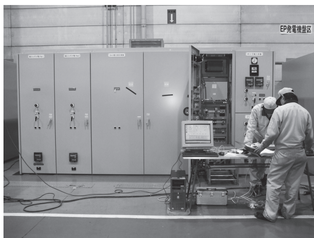
発電機盤の完成検査作業
