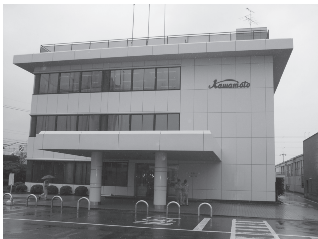
川本製作所 岡崎工場の管理棟
