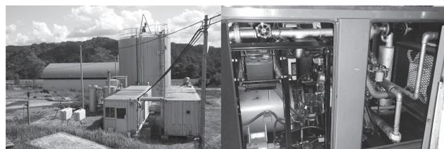
足寄町蝶湾地区(奥足寄)の新妻牧場では平成17年度から牛糞を発酵し抽出したメタンガスを燃料に利用している。牛300頭から日量18tの牛糞等を回収し、55℃で発酵し嫌気処理して日量525㎡のメタンガスを製造し、ガスと軽油のデュアルフェューエル燃料式30kWコージェネシステム×1基、140kWボイラー×1基に供給している。熱は加温用に利用している。
