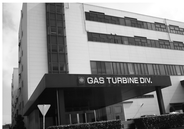
ガスタービンビジネスセンター
