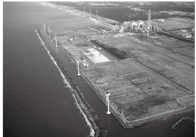
護岸と離岸堤間の水路部に設置された風力発電機（5基）。中央上には陸上に設置された3基の風力発電機も見える。
