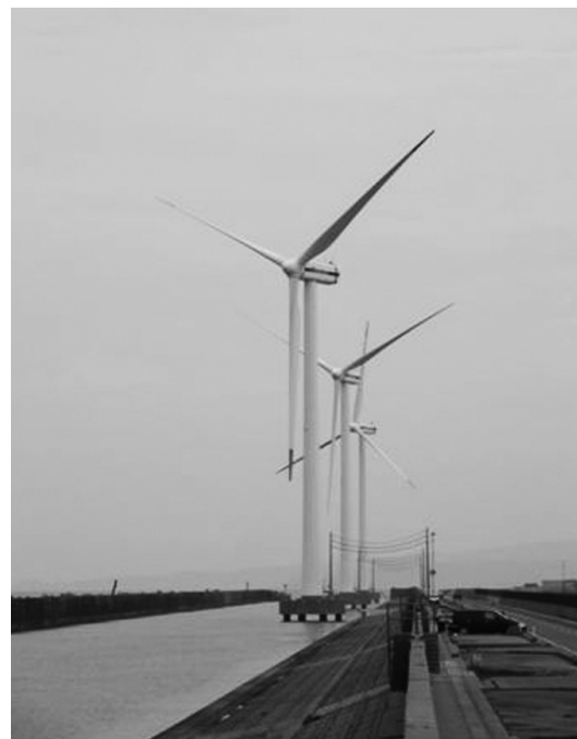
写真右はヴェスタス社製(デンマーク)2000kW風力発電機。 写真左は宮海海岸部に設置された同じタイプ3基と後景は鳥海山。
