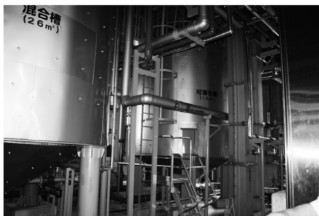
写真7 可溶化槽
