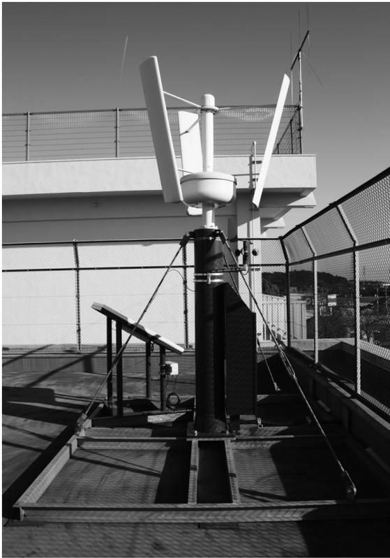
写真3 垂直翼型のハイブリッド型発電設備
