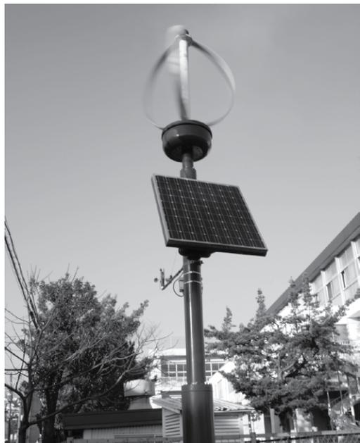
写真2 ダリウス型のハイブリッド型発電設備
