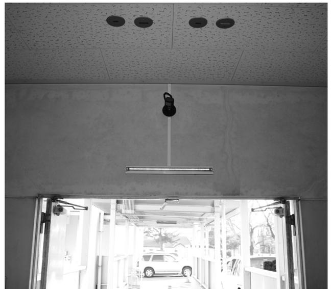
写真5 人感センサーセンサー付き照明器具
