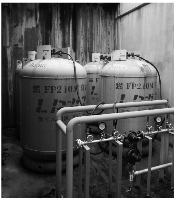
都市ガス遮断時に使用されるLPガス備蓄ボンベ
