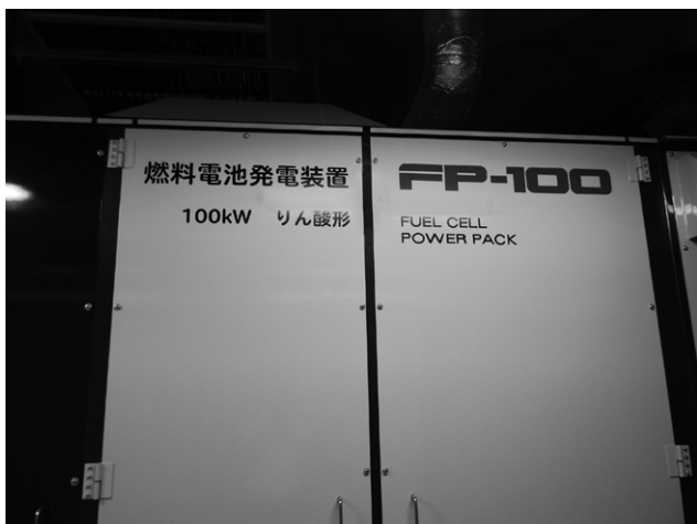
100kW リン酸形燃料電池
