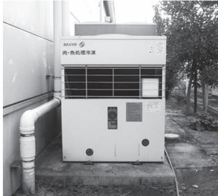
食材の冷蔵・冷凍用の冷凍機システム
