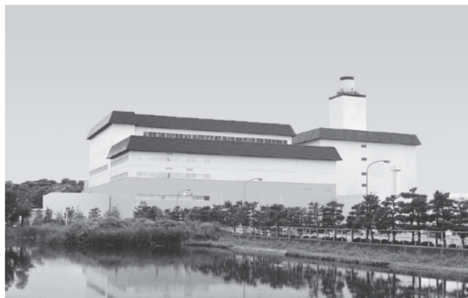
仙台火力発電所
