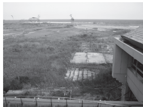
手すりの曲がった屋上から太平洋側をのぞむ。コンクリート校舎が児童と教職員の命を守った
