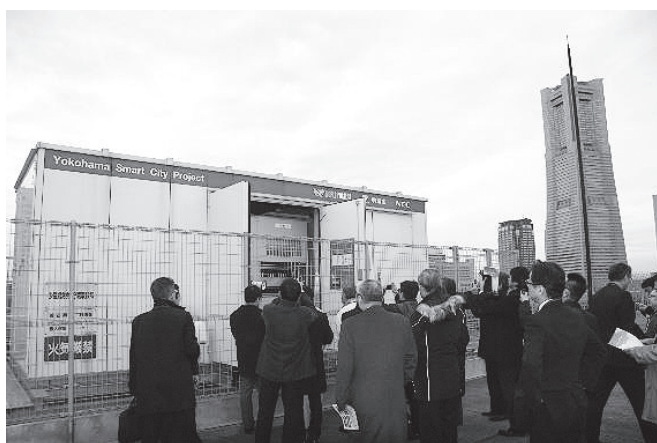
蓄電池システム
