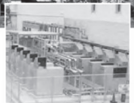
石川県犀川 さい 左岸浄化センター に納入した25kW×12台
