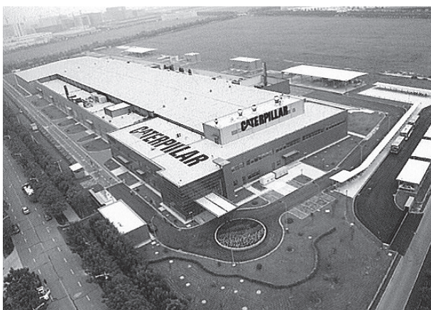
天津工場外観（工場案内資料から）
